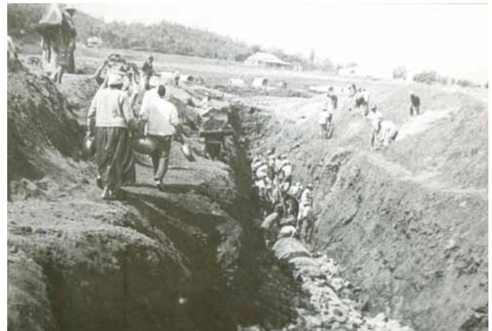
강화지역 새마을사업 농수로 토관 매설 작업(1970)
