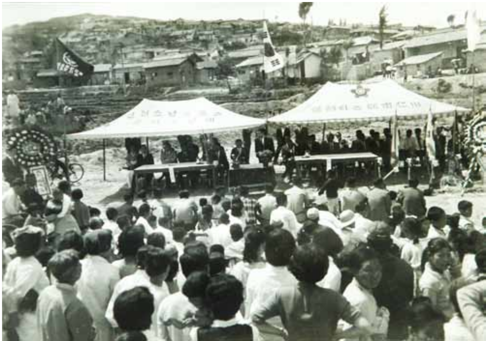
상이용사촌 건설 기공식(1967) 6·25전쟁에서 부상당한 상이용사들과 월남파병 상이용사들을 위한 주택과 공동 작업장 등이 인천 교외 곳곳에 세워졌다.
