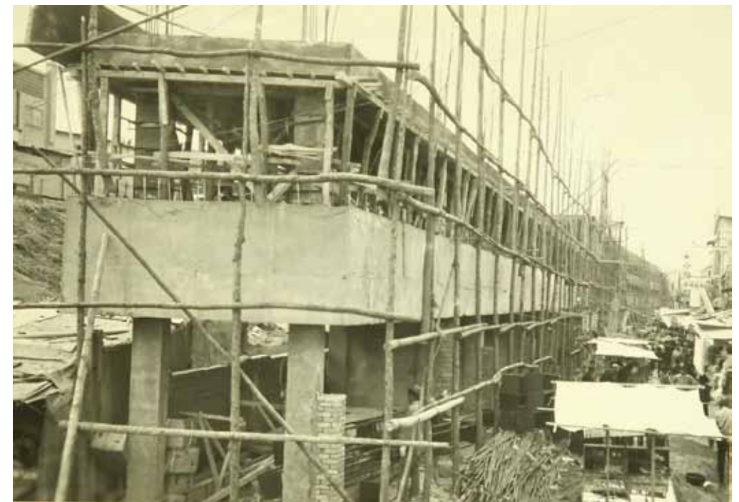
중양시장 공사 현장(1971) 동인천역 뒤편의 중양시장은 경인선 철로변을 따라 형성되었다. 시장 전체를 3개 구역으로 나누었는데 철길 따라 형성된 곳을 갑(甲)구 상가라 칭했고 맞은 편은 2개 구역으로 구분해 금곡동(배다리) 쪽을 을(乙)구, 화평동 쪽을 병(丙)구 상가로 불렀다. 불나기 쉬운 기존의 목조 상가를 헐고 당시에는 보기 드문 3층짜리 콘크리트 주상 건물을 지었다.
