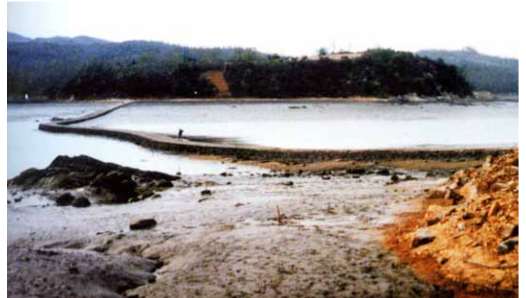
길상면 동검리 제방도로 공사전(1983)
