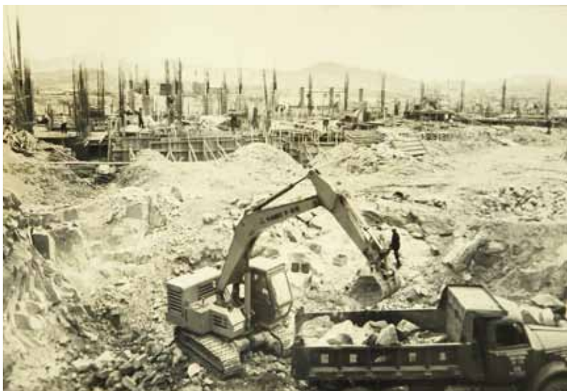
도원실내체육관 공사 현장(1971)
