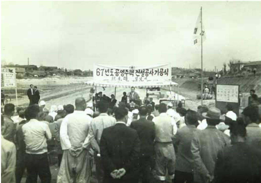
시 공영 연립주택 건설 공사 기공식(1967)
