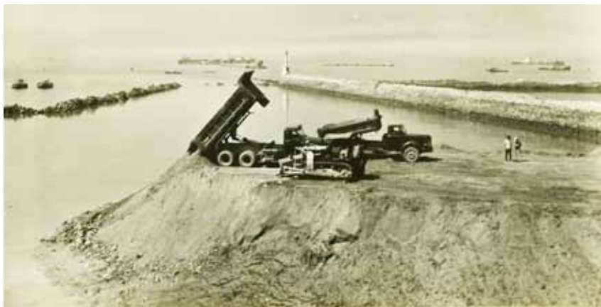
소월미도 매립지 공사(1971)
