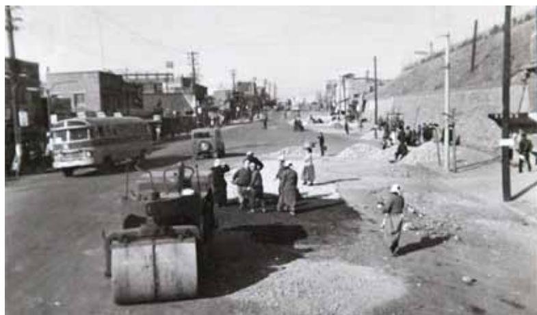
담동성당 앞길의 도로 포장 공사(1965) 장비라곤 로울러 차와 돌을 나르는 삼태기뿐이다. 후에 오른쪽 언덕에 가톨릭회관이 들어선다.
