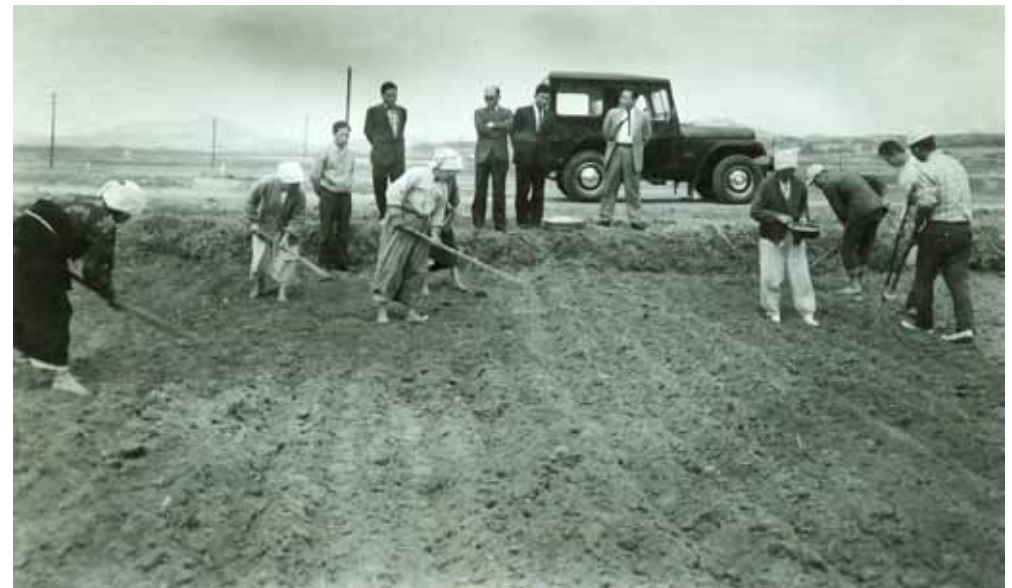
고잔동의 건담 직파 작업 현장(1966)
