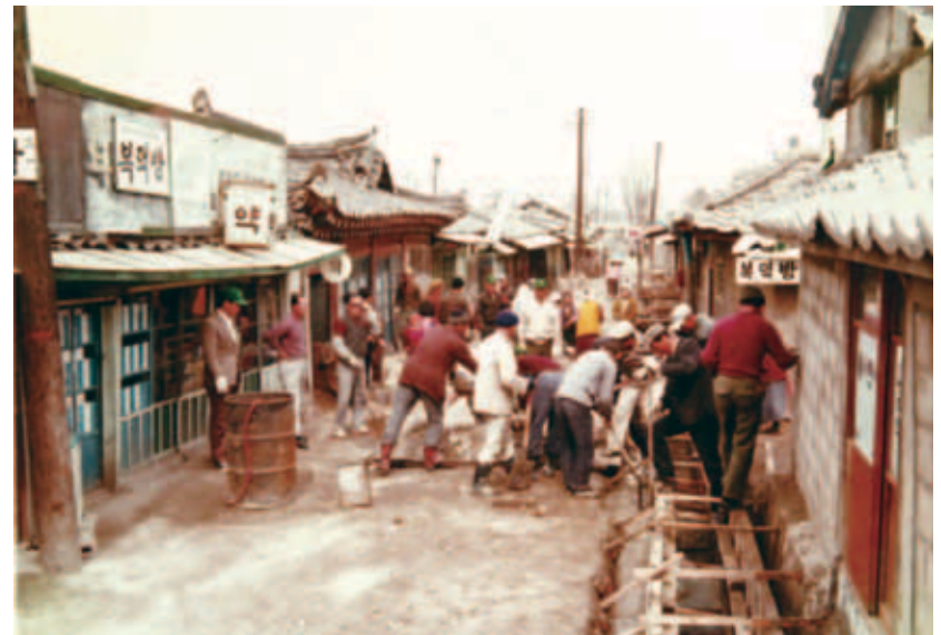
부평지역 하수도 공사(1973)
