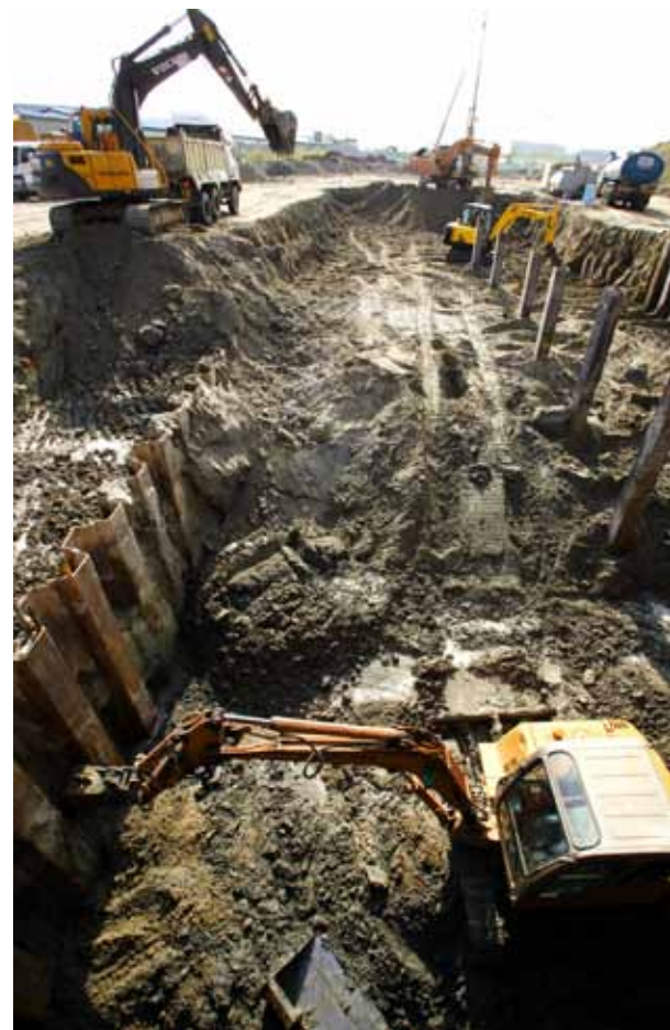
인천지하철 1호선 송도 연장구간 공사
