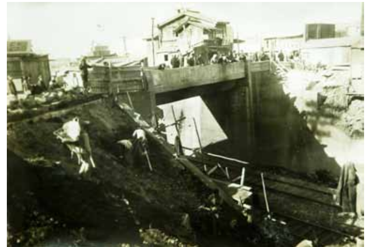
인천극장 앞 전동운교 확장 공사(1967)
