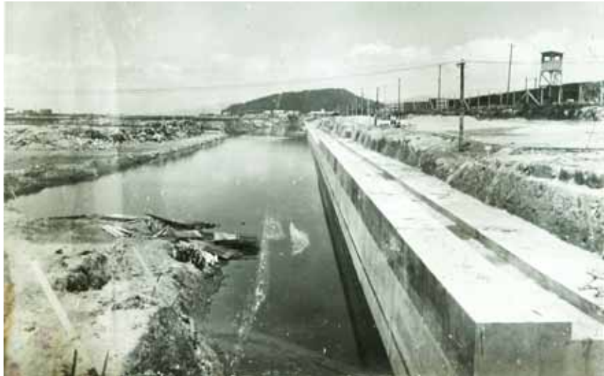
제2도크 공사 현장(1967)
