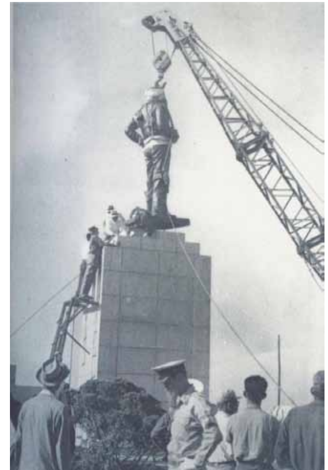
맥아더장군 동상 건립 작업 광경 인천상륙작전의 성공과 그 의미를 담아 1957년 인천의 만국공원에 맥아더장군 동상을 세우고 자유공원이라 개칭하였다.
