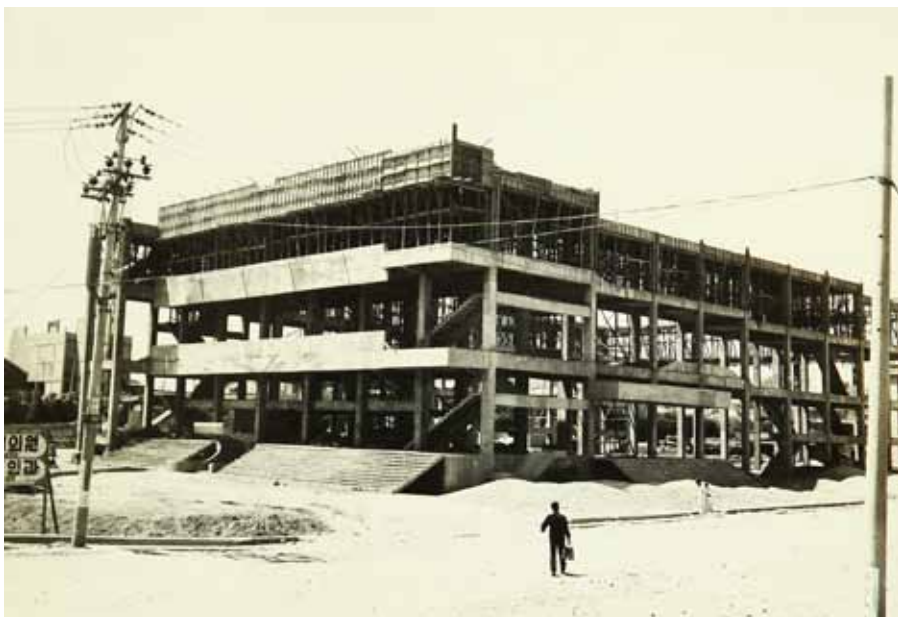
주안시민관 공사 현장(1971)
