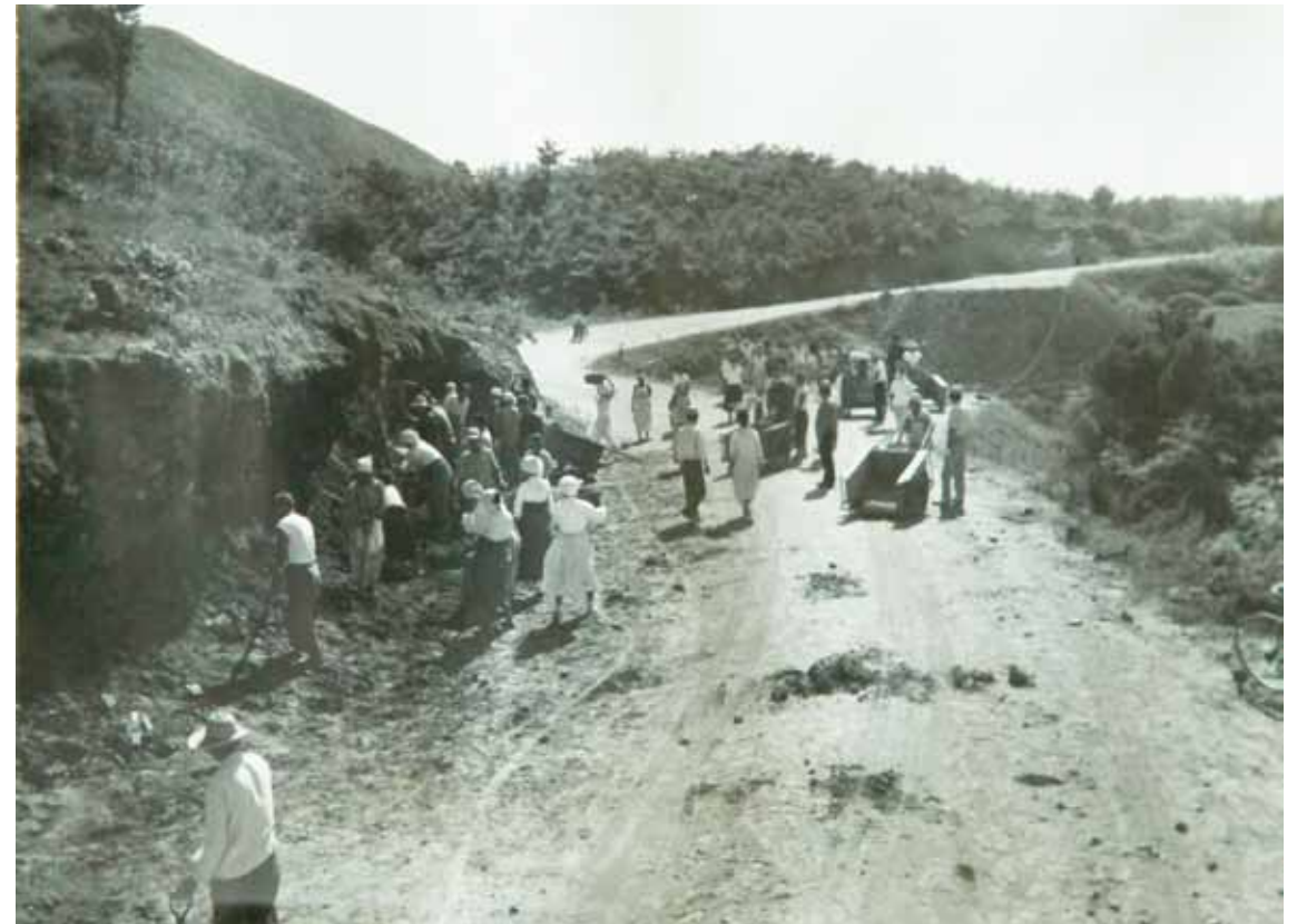
서구 도로 확장 공사(1965)
