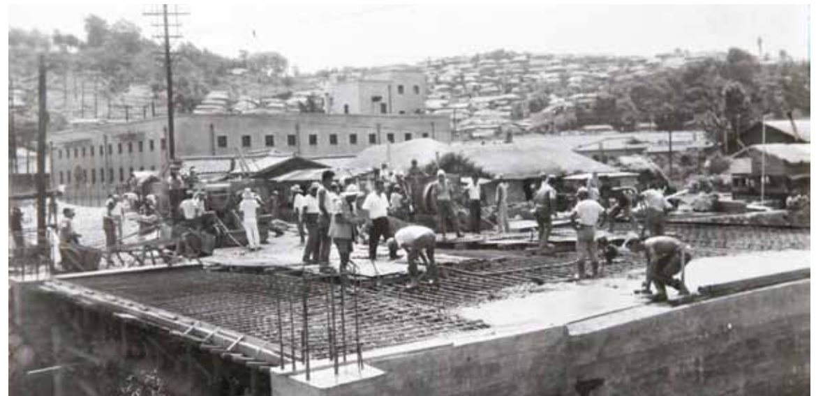
수문동 송현교 개수 공사(1966)
